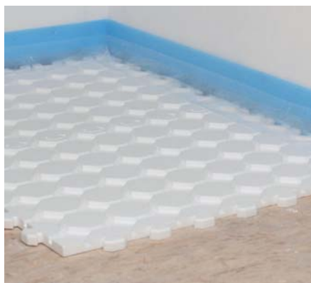
1) Systemplatte Climate 25 in einer Raumecke beginnend fugendicht unter die Folienschürze des Randdämmstreifens verlegen.
