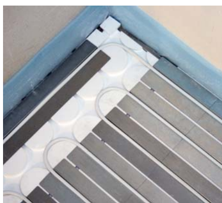
4) In die fertig verlegten Wärmeleitlamellen das Heizrohr (Ø 14 mm) einfach fixieren. Wir empfehlen die Verlegung nach Mäander-Art.
