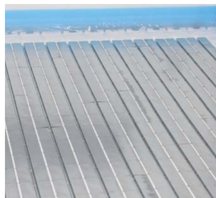
3) Wärmeleitlamellen mit 5 mm Abstand anpassend verlegen. Sollbruchstellen garantieren eine optimale Anpassung (bitte Arbeitshandschuhe tragen).
